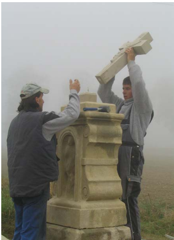
Instalace opraveného pískovcového křížku u cesty ke Kubovce – 24.9.2010 (Oprava byla zrealizována za pomoci dotace z Programu rozvoje venkova, osa IV. LEADER)
