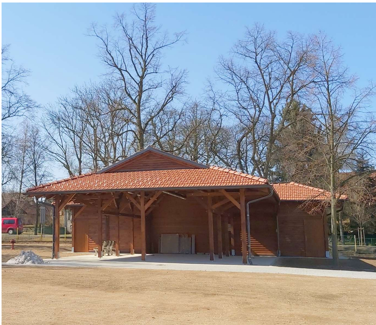
Venkovní učebna - altán ve škole
